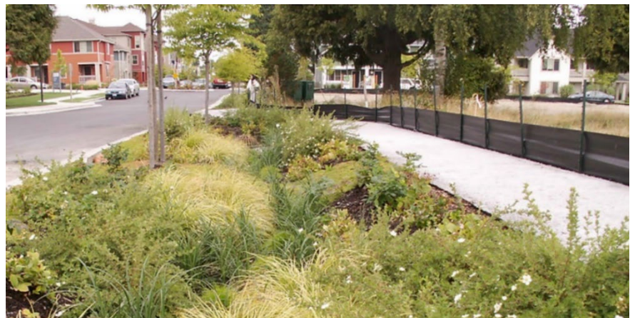
Un sistema de drenaje natural terminado.
