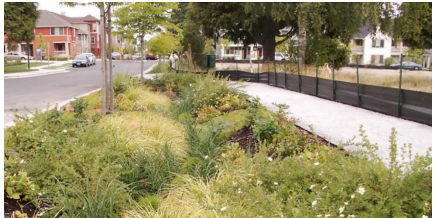
Hệ thống thoát nước tự nhiên đã hoàn thiện.
