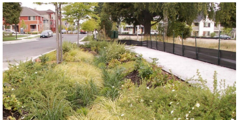
Un sistema de drenaje natural terminado.
